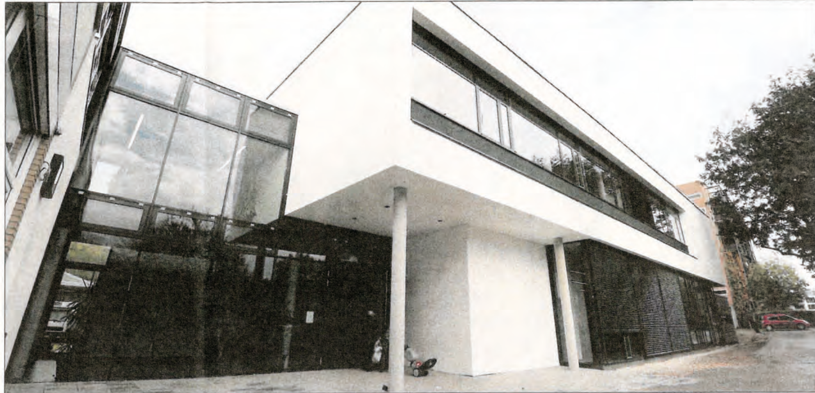
Die Adalbert-Stifter-Schule in der Pliensauvorstadt ist in den vergangenen Monaten zu einer modernen Werkrealschule mit ausreichenden Räumen für den Ganztagsbetrieb umgebaut worden. Das Herzstück der Umgestaltung ist ein Anbau, in dem die neue Mensa Platz findet. Foto: Kaiser
