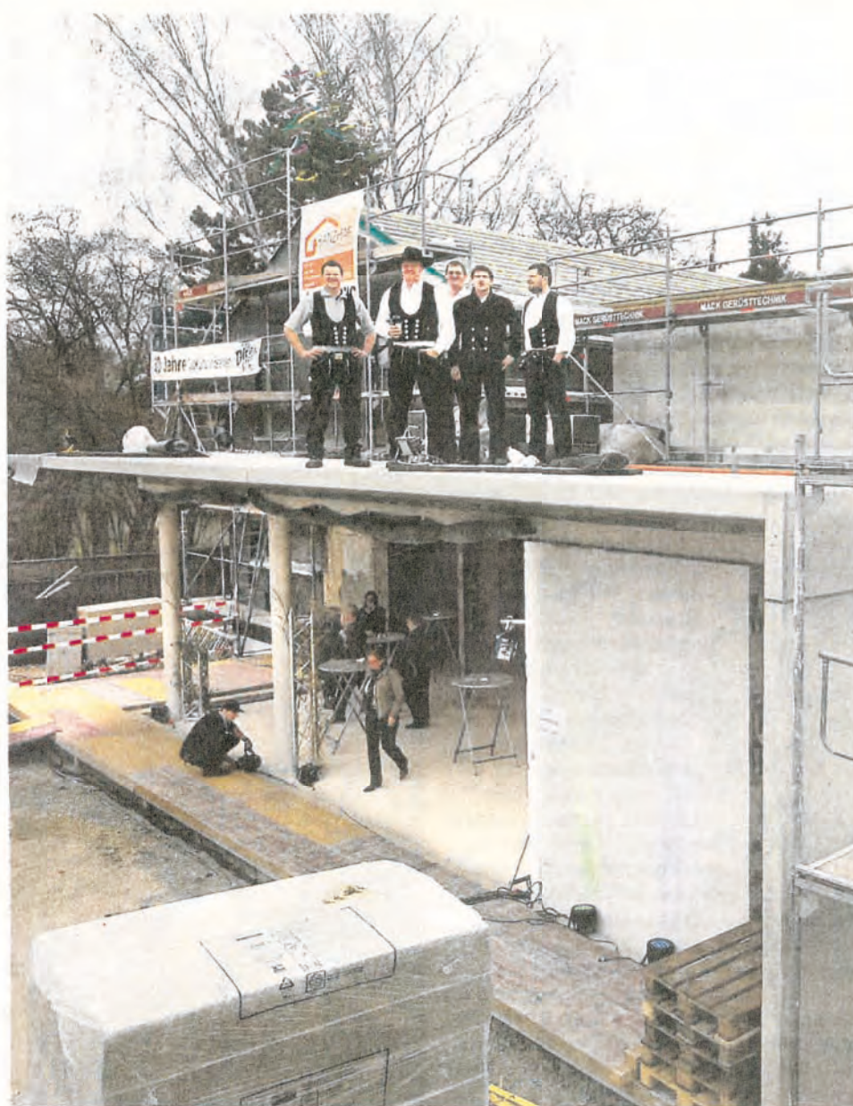
Die Zimmerleute stehen auf dem Foyer des neuen Gebäudes.
